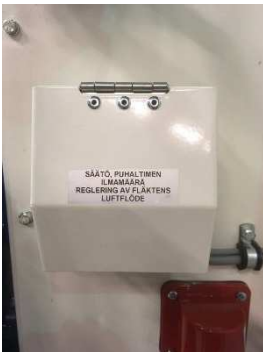
Puhallin, nopeussäätö (kannen alla) sekä 16 A kojevastake syötölle (punainen)
