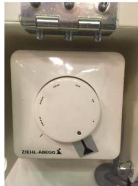
Kuvassa ”max”-nopeus Kierrä myötäpäivään ”max” ja vastapäivään ”off”-asentoon
